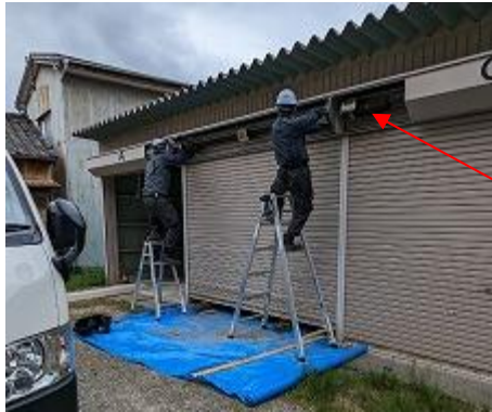
手動シャッターの開閉器「スプリングシャフト」バネの力で凄いですね！
